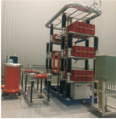
图2 整只避雷器大电流冲击试验平台实物
